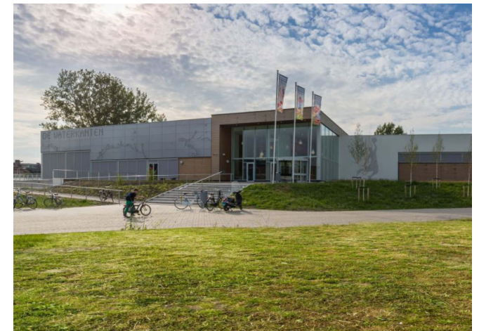
Parkeergarage geïntegreerd in het sportgebouw Sportcentrum De Waterkanten, Lisse
