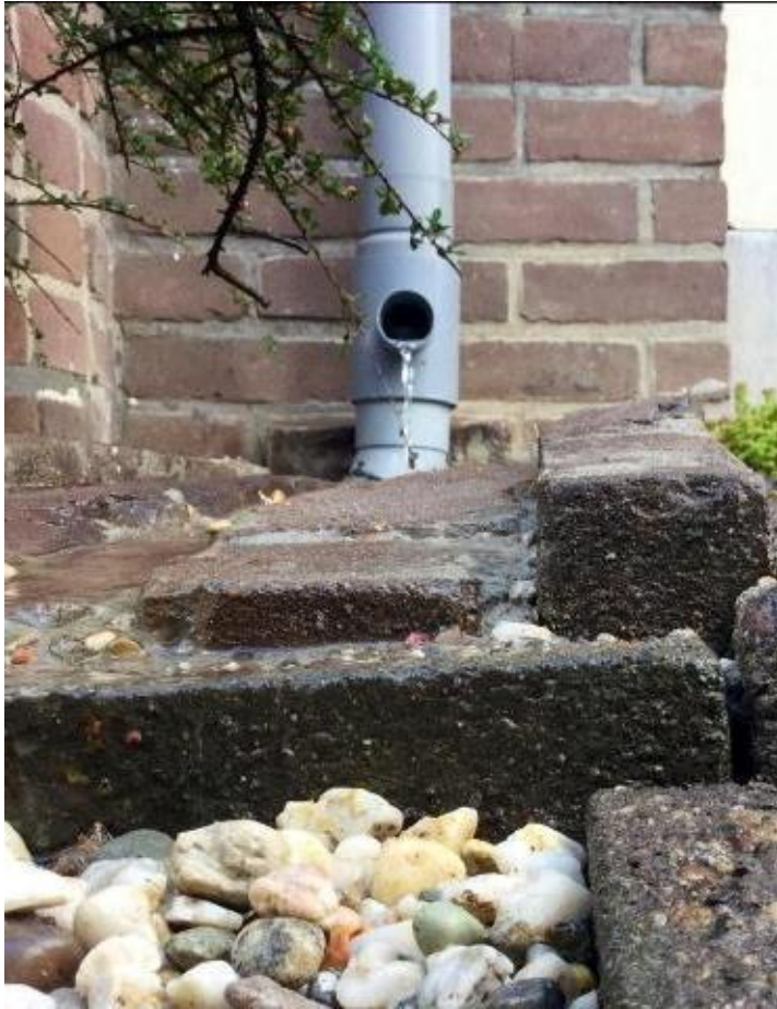
Afkoppelen van hemelwater in de voortuin
