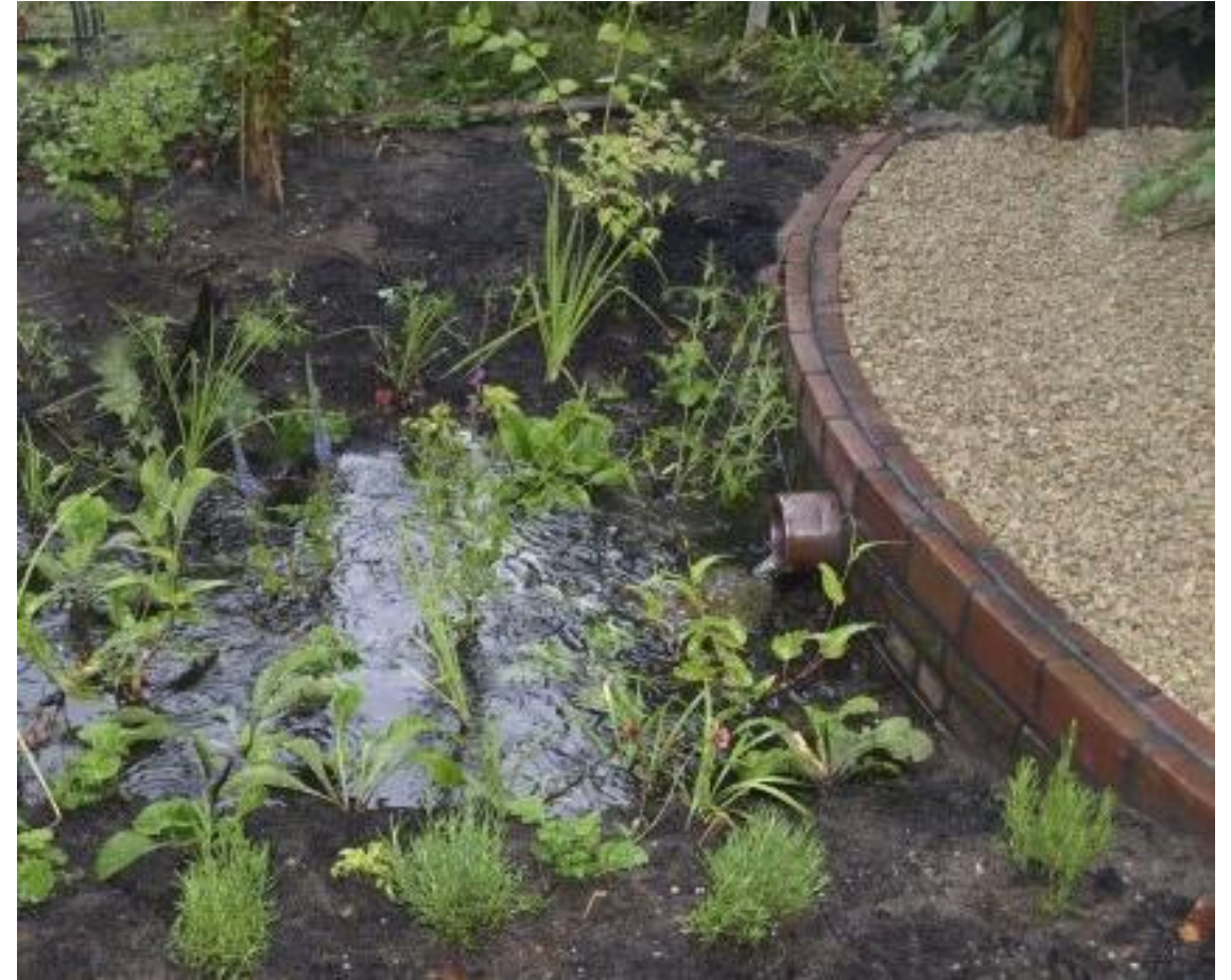
Afkoppelen van hemelwater en infiltreren in de achtertuin
